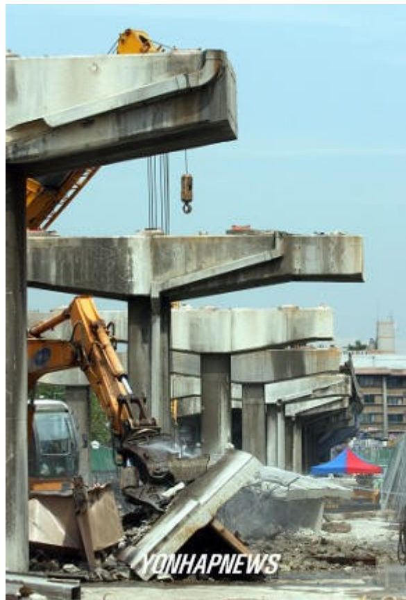
Demolição da autopista elevada.
