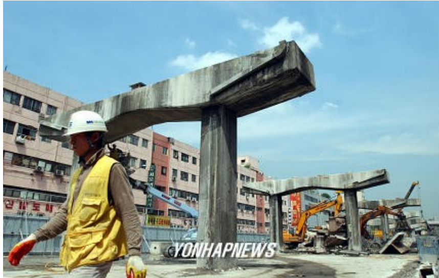
Demolição da autopista elevada.
