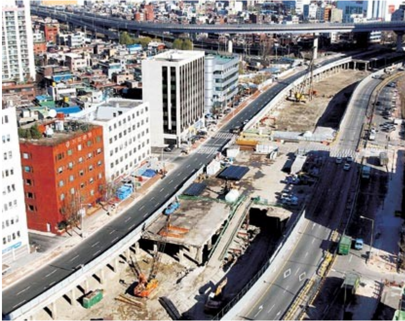
A demolição da autopista começou em Julho de 2003.
