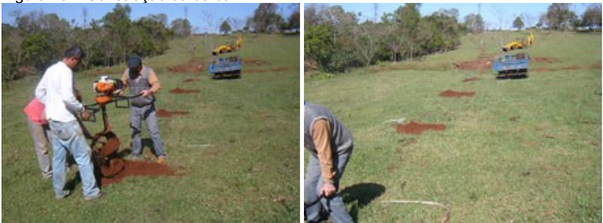
Figura 19 – Construção da cerca
