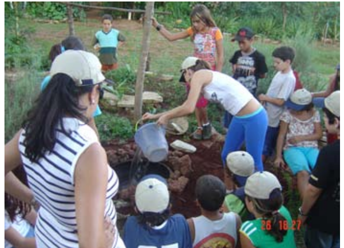
Turma de estudantes do Colégio Cresça construindo um tanque de pneu no Ecocentro IPEC
